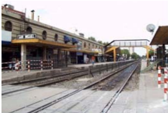
Foto N° 2. Estación San Miguel
