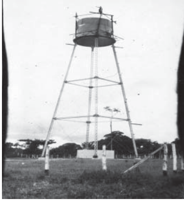
Foto No.7. Montaje del tanque para el acueducto. Cortesía. Marina de Tono
