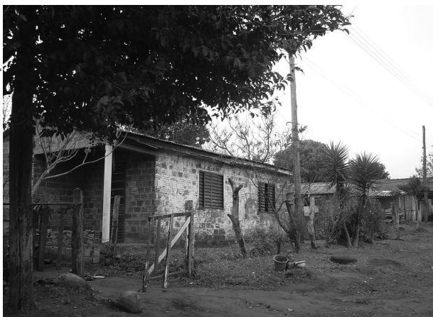
Foto 11 – Casas e processos de urbanizações inacabados – construções envelhecem sem terminarem de serem construídas devido à precária condição de trabalho dos moradores.
