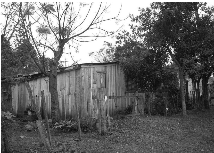
Foto 13: Casas e vidas em condição de precarização na periferia urbana de Cruz Alta.
