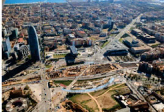
Figura 7 - Panorámica del lado mar, de la transformación de las Glorias y urbanización provisional de espacios no afectados por las obras
