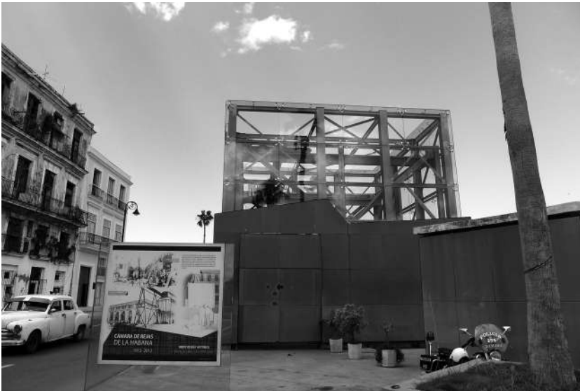
Fotografía 4. Cámara de rejas de La Habana, Cuba.
