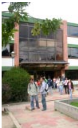
Detalle Edificio de aulas Rafael Azula Universidad Pedagógica y Tecnológica de Colombia - Tunja
