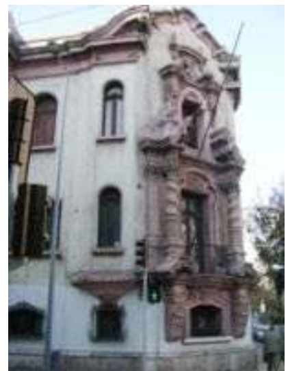
Figura 6 - Casa Ariztía. Chile
