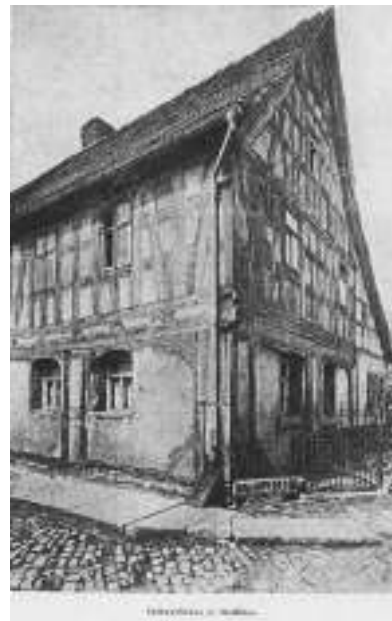
Adaptación del sistema constructivo. Fachwerkhaus in mutschau.
