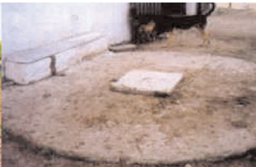
Depósito de almacenamiento para riego con estercolera
