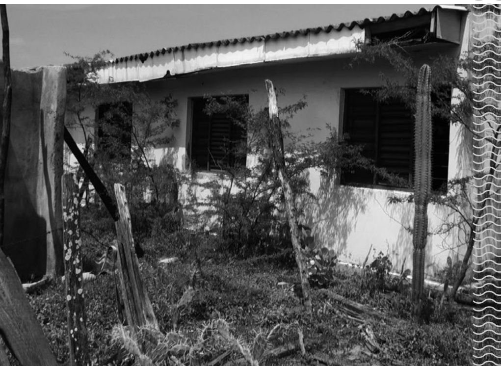
CENTRO DE SALUD DE ROCHE, ACTUALMENTE ABANDONADO.
