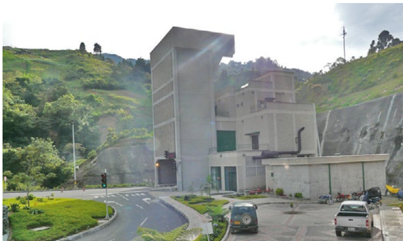
Figura 29. Fotografía de inicio del Túnel de Occidente
