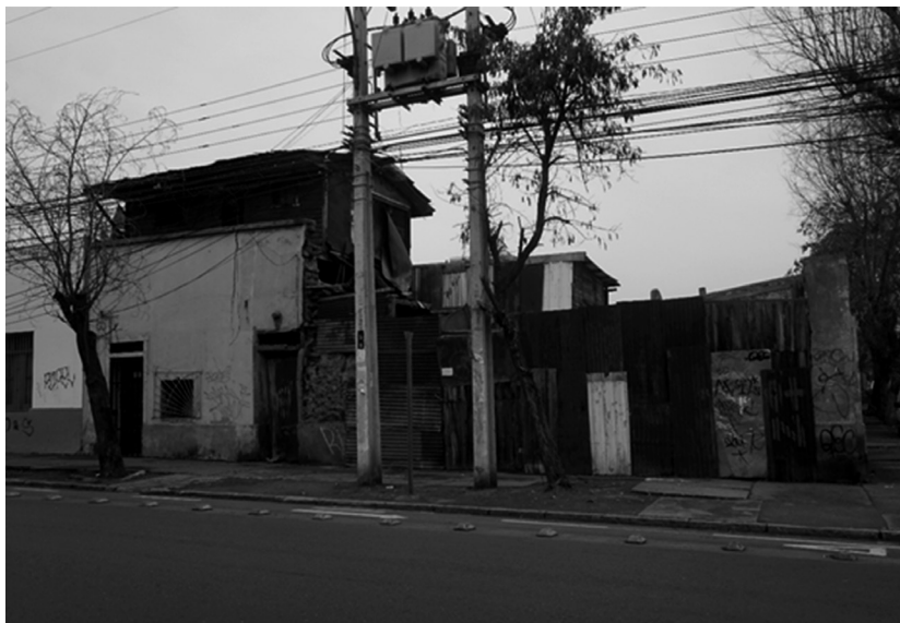
Antigua Casa de Remolienda/Quinta de Recreo "Donde Miguelito" de la calle Francisco Lobos. La mayor parte de la casa se destruyó para el terremoto del año 2010. Fotografía: Roberto González Loyola.
