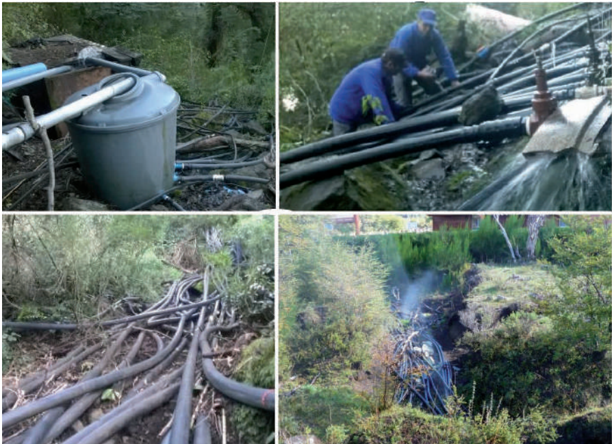
FIGURA 15. REGISTRO FOTOGRÁFICO DE LAS CAPTACIONES DE AGUA CONSTRUIDAS EN LAS VERTIENTES DEL VALLE DEL RENEGADO, DE ARRIBA A LA IZQUIERDA, A ABAJO A LA DERECHA: CAPTACIÓN PARA UN CENTRO TURÍSTICO, TUBERÍAS DE PLÁSTICO CONECTADAS A UN ESTANQUE DE FIERRO, QUE POSTERIORMENTE SE ENCUENTRAN CONTAMINANDO EL PAISAJE DEL VALLE
